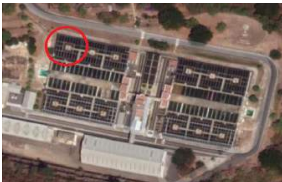
Foto 13.1: Localización clarificador a rehabilitar
