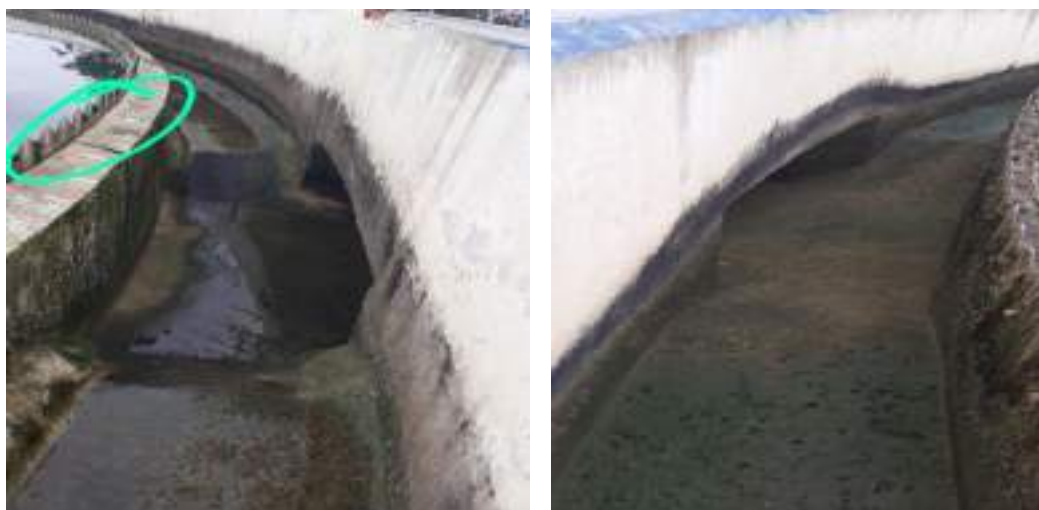
Foto 13.3: Vertederos clarificadores D°25m y D°28 m
