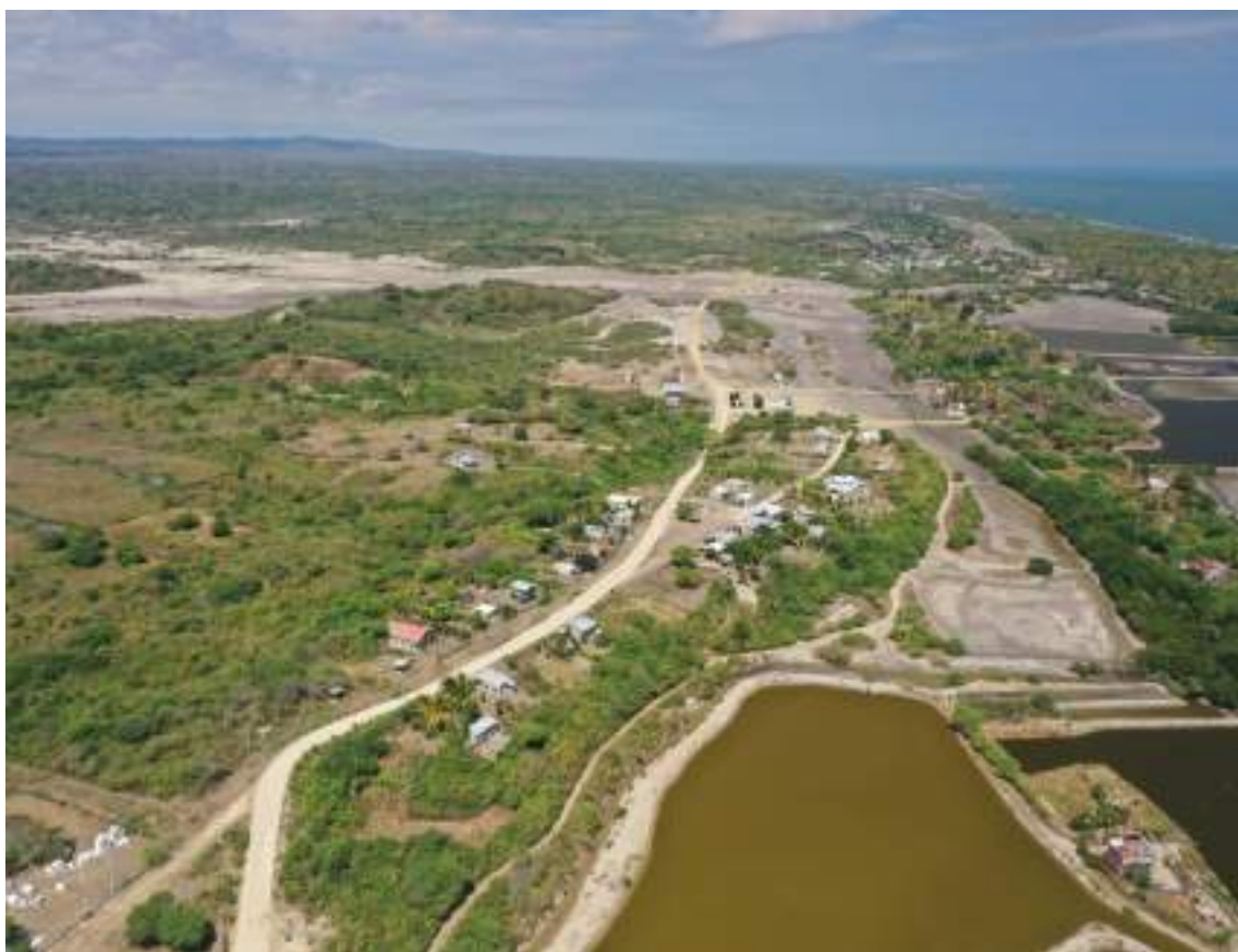
Foto 13.15: Recinto ESTERO DE BOCA
